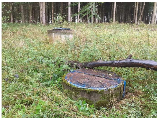
Obr. č.2 studna S4 s armaturní šachtou
