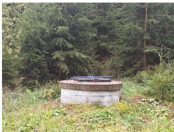
Obr. č.3 posilující studna S6 z roku 2000
